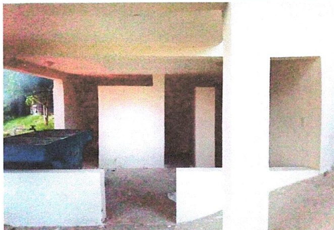
Foto1: MEJORAMIENTO DE ÁREA DE PASILLO CON UNA CONTENCIÓN QUE SE APRECIA AL FONDO E INSTALACION DE SERVICIO SANITARIO
