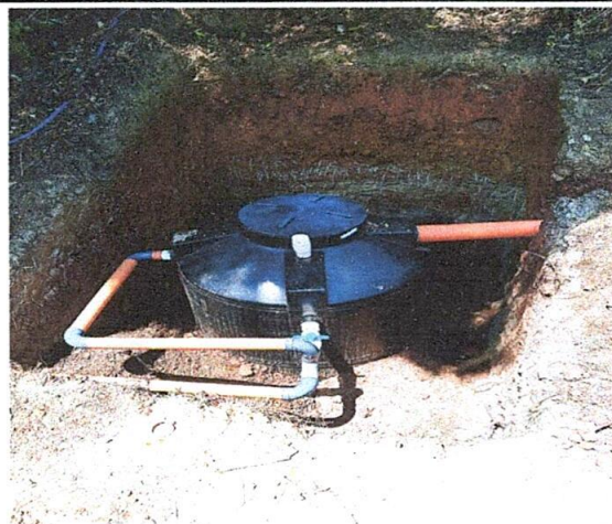
Foto 2: MEJORAMIENTO E INSTALACION DE SERVICIO SANITARIO CON BIODIGESTOR
